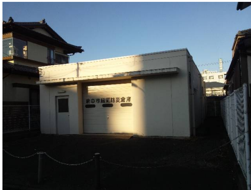
非難想定場所への移動中に見つけた防災倉庫
